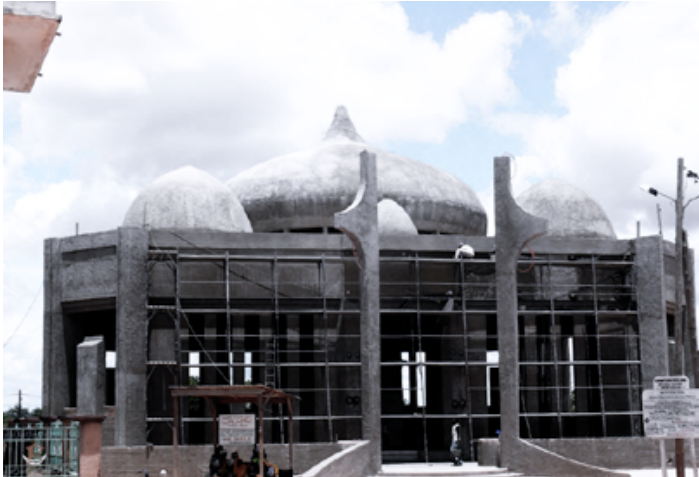
Le mausolée de Sokhna Diarra Bousso à Porokhane en chantier
